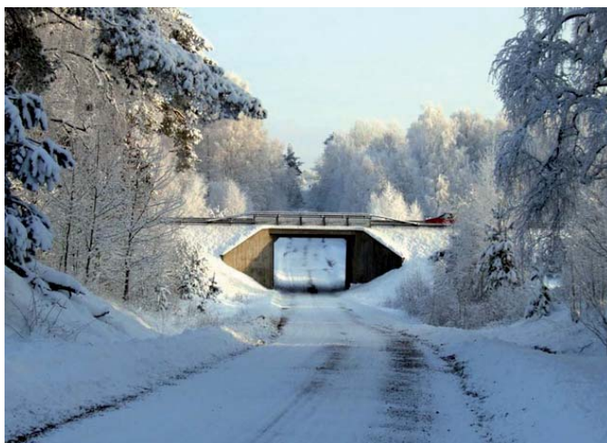
Grenadjärgatans förlängning under Rv 32 mot Ränneslätt.
