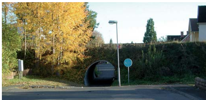
Cykeltunnel under järnvägen vid Mariebergsgatan.
