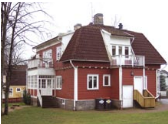
Byggnad 3 Fasad mot söder och öster
