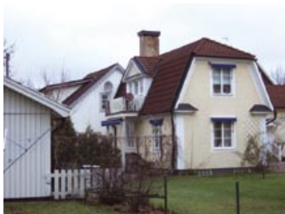
Kaplanen 6. Fasad mot söder
