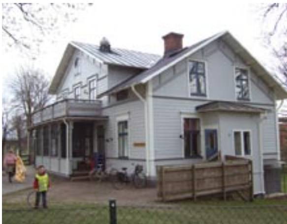
Byggnad 1. Fasad mot öster och norr
