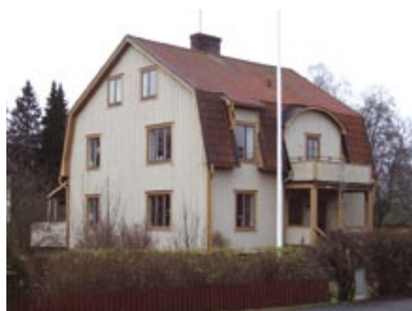
Hammaren 3. Fasader mot söder och öster. Här har sannolikt fönstren blivit utbytta under 1940-50 talet
