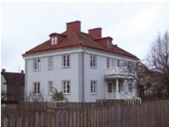
Fasader mot söder och öster
