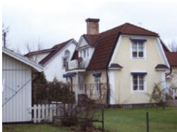
Kaplanen 6. Fasad mot söder
