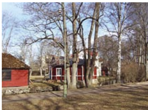
Byggnaderna utefter Eksjö ån. Fasader mot öster
