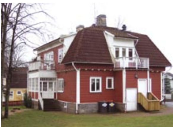
Byggnad 3 Fasad mot söder och öster
