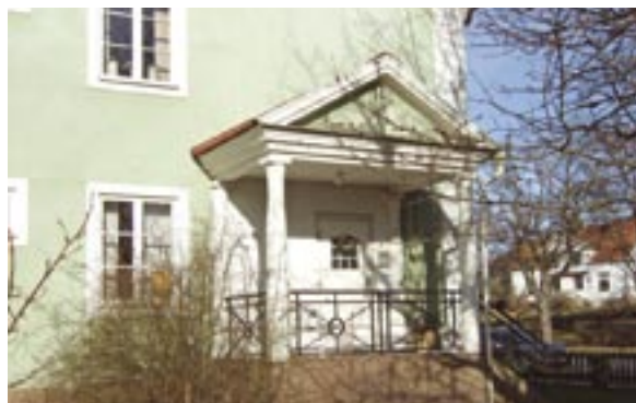
Entré till byggnad i kvarteret. 20-tals klassicism
