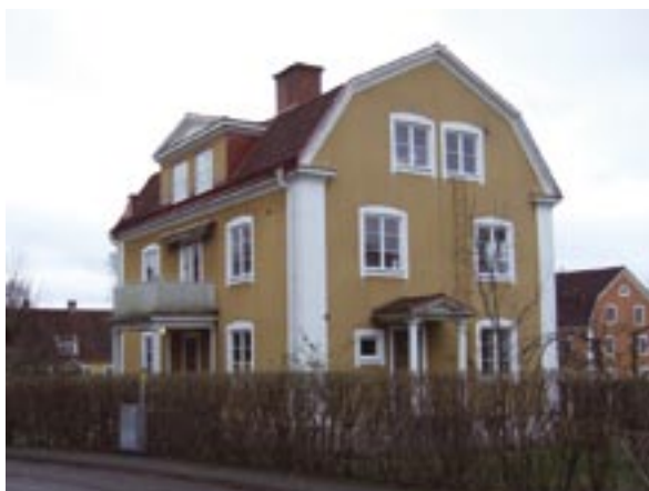
Fasader mot öster och norr
