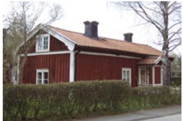
Fasad mot söder och öster
