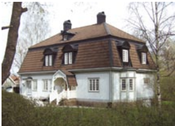
Fasader mot nordväst och söder
