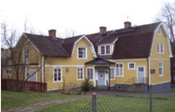
Byggnad 2. Fasad mot norr och öster
