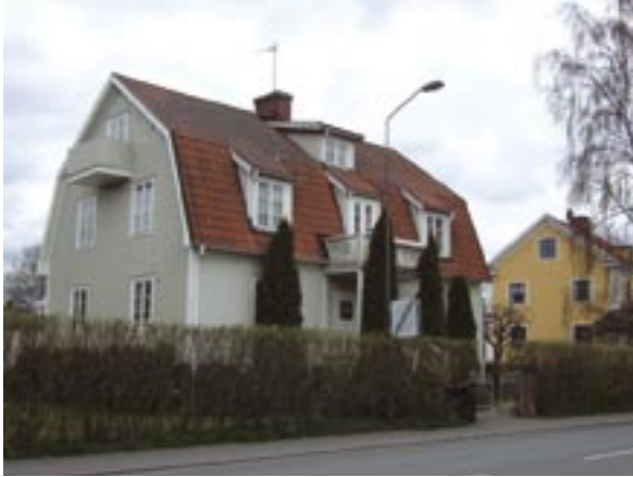
Muraren 1. Fasader mot söder och öster
