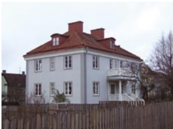
Fasader mot söder och öster
