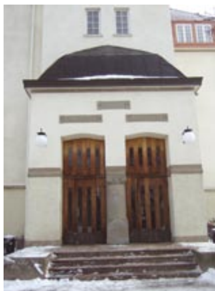
Huvudentrén med originaldörrar. Mittpelaren utgörs av en massiv kalkstenspelare
