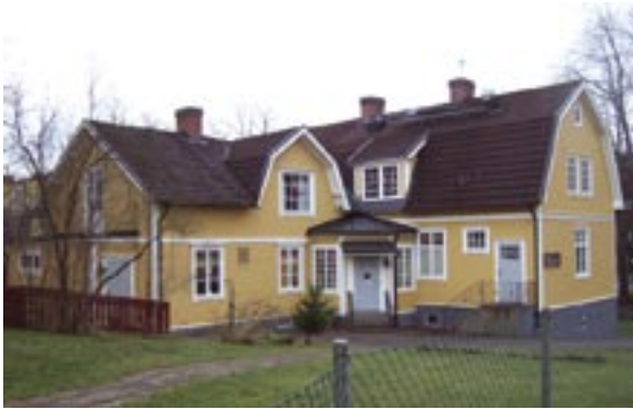
Byggnad 2. Fasad mot norr och öster
