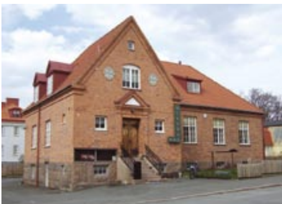
Fasad mot Läroverksgatan
