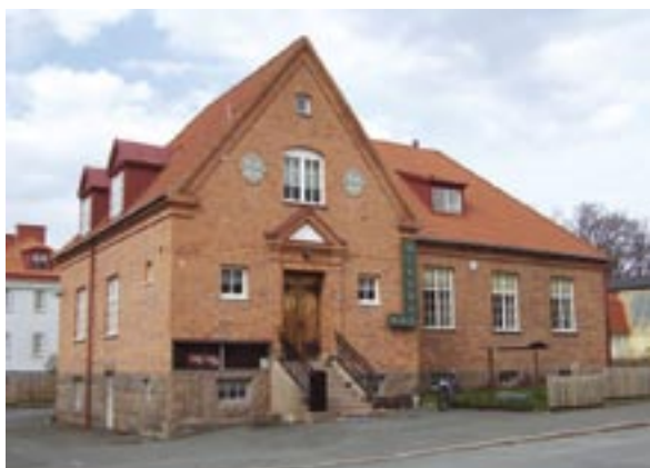
Fasad mot Läroverksgatan
