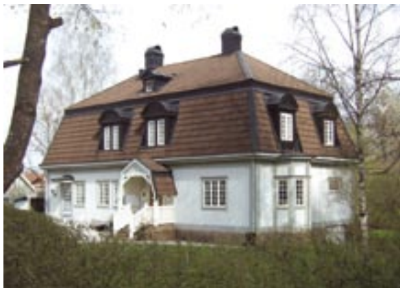
Fasader mot nordväst och söder
