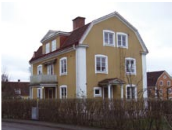
Fasader mot öster och norr
