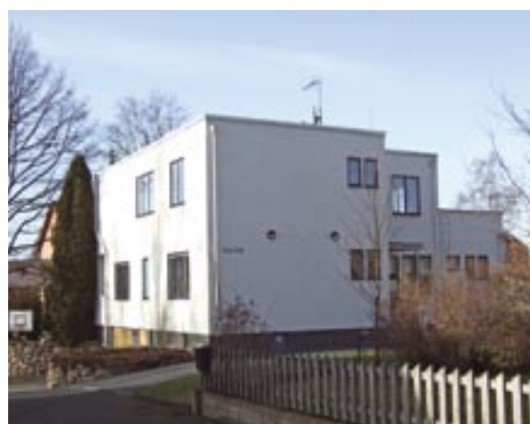
Fasad mot söder och öster
