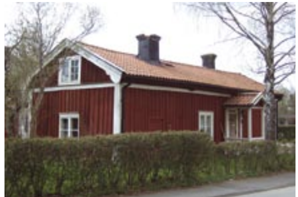
Fasad mot söder och öster
