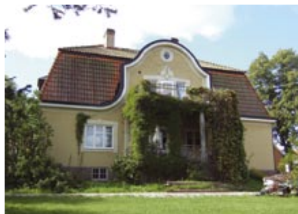
Byggnaden har troligen uppförts under tidigt 1900-tal i arkitekturstilen jugend. Fasaderna förefaller intakta sedan tillkomsten.
