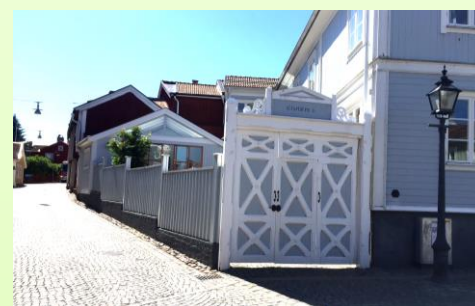
Planket är medvetet anpassat för att för att smälta in med tillhörande byggnader
