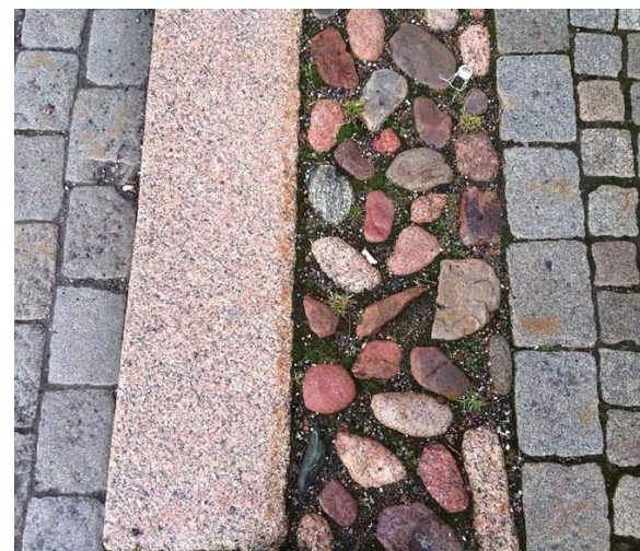
Markstenbelägning på Södra Storgatan i Eksjö
