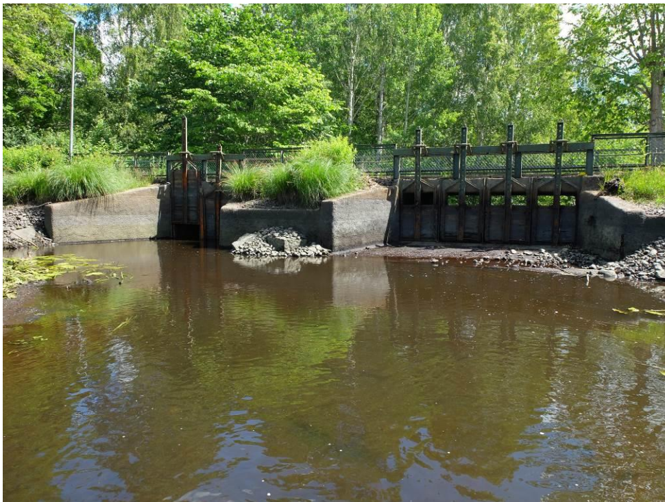
Figur 4. Nedre bruksdammen i Mariannelund, sedd från uppströmssidan när dammen är avsänkt strax under tröskelnivån för skibordet (till höger i bilden)
