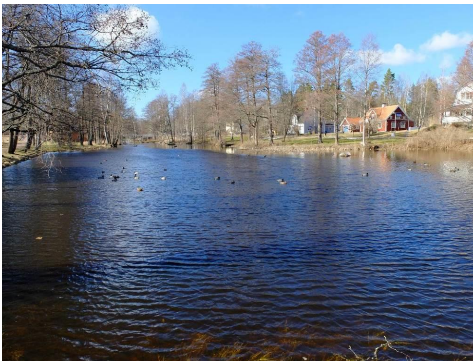
Figur 3. Dammspegeln vid nedre bruksdammen i Mariannelund, när dammen är i övre dämningssgräns.
