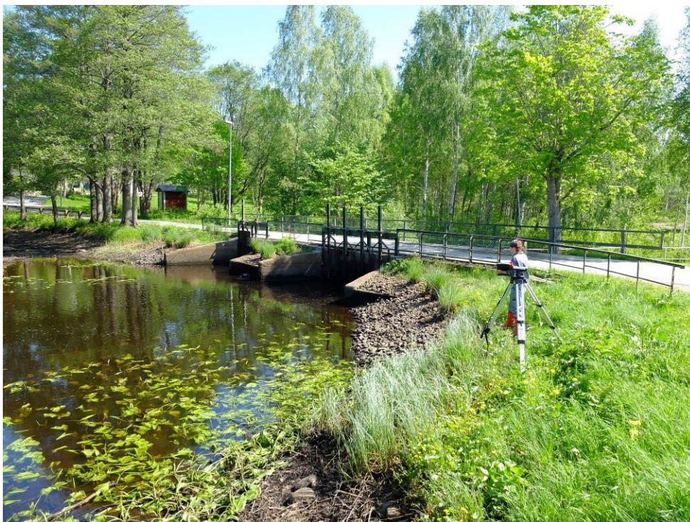
Figur 5. Nedre bruksdammen vid Mariannelund sedd från södra sidan. Vägöverfarten utgör del av Esmarchsgatan.
