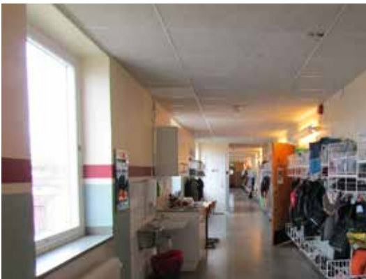
Siktlinjerna i skolans korridorer bryts av de sentida toalettutrymmen som uppförts.
