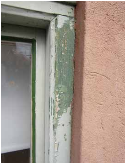
På källarvåningens fönsterbågar är fönstrens ursprungliga färgsättning tydlig.
