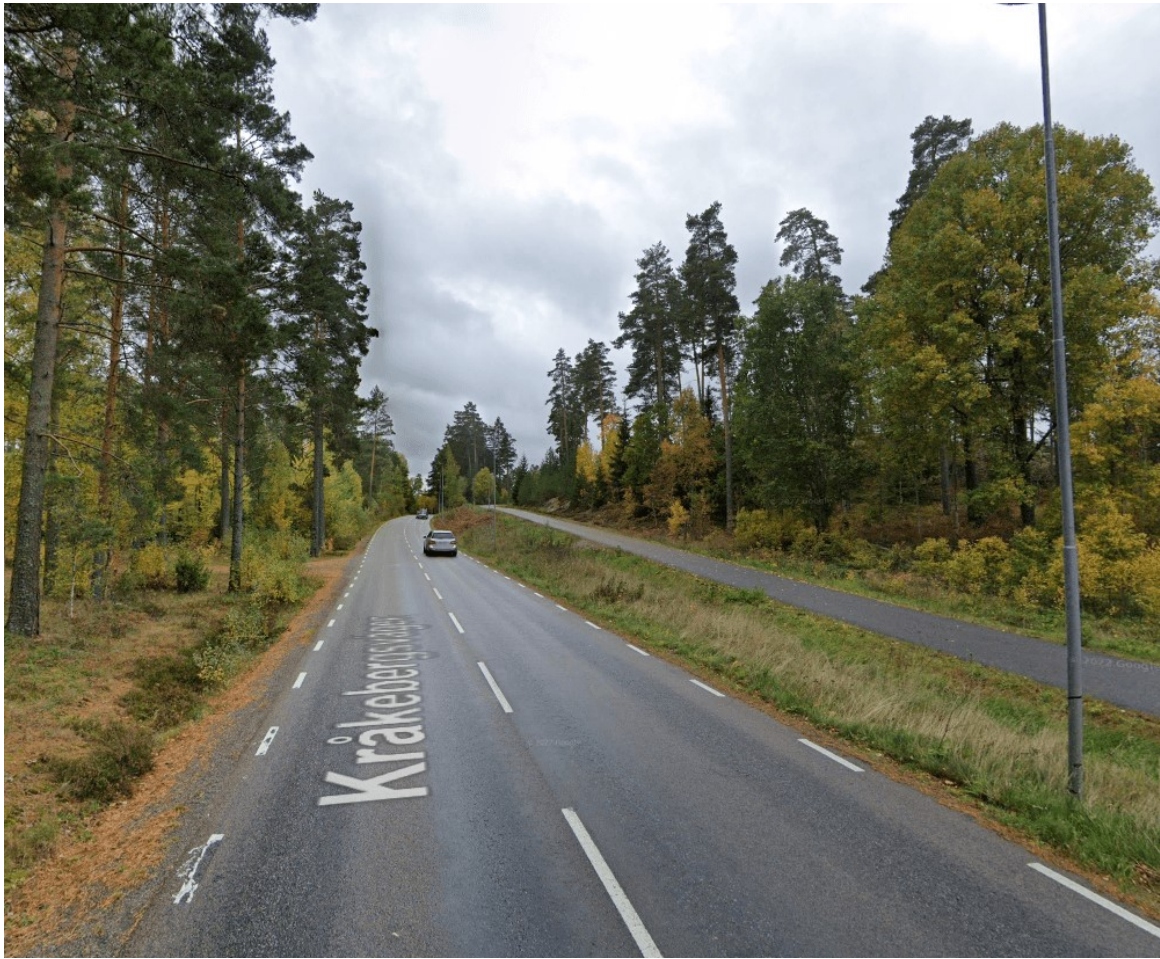
Figur 12: Vy över Kråkebergsvägen i riktning mot söder.
