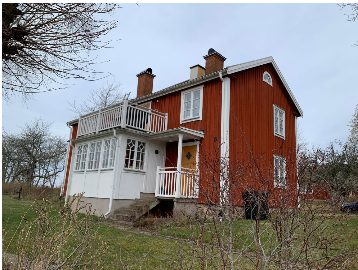
Figur 5: Bilden visar befintligt bostadshus inom detaljplaneområdet som omfattas av införandet av varsamhetsbestämmelse kopplat till dess kulturhistoriska värden, med särskilt fokus på fönstren, dess färg, form och placering samt snickeridetaljer.
