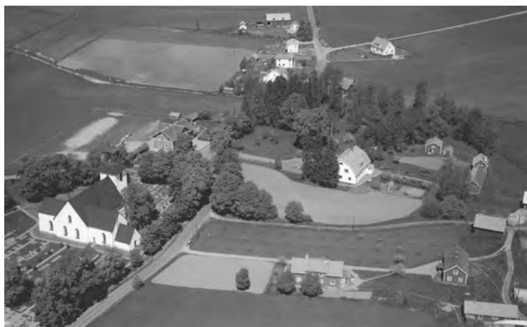
Flygfoto från 1954. I förgrunden ses kyrkan, prästgården och lönebostället. Mitt emot prästgården ses skolhuset från 1870. I norr ses några bostadshus, varav två inrymde butikslokaler, samt en verkstadsbyggnad. Foto: Jönköpings läns museum, JM.2001-5-1091.
