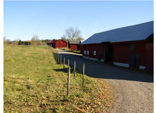
Byns bebyggelse ligger samlad söder om den grusade byvägen. Närmast gatan ligger gårdarnas ekonomi-byggnader.
