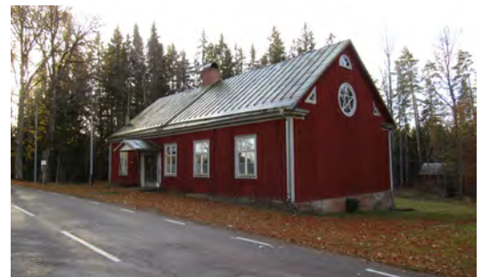
Det f.d. missionshuset Fridhem uppfördes 1863 och minner om bygdens tidiga och livaktiga frikyrkotradition.
