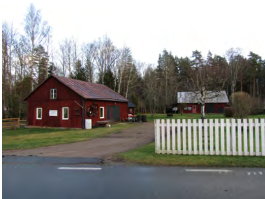
Byggnaden har inrymt Värne smedja som är utpekad som en värdefull industrimiljö i Länsstyrelsens industriinventering.
