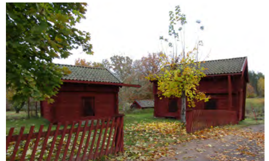
I anslutning till byns mangårdsbyggnader finns ett flertal timrade bodar och andra uthus samt jordkällare. (Hultåkra 1:7)
