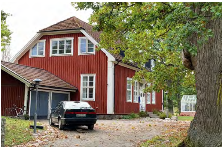
Det f.d. skolhuset uppfört 1922. (Brevik 3:7)
