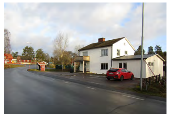
En av de byggnader i samhället som ursprungligen inrymt handelsverksamhet.
