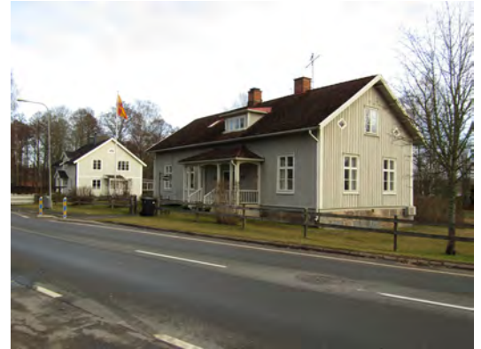
Det f.d. skolhuset i Bellö uppfört 1882, idag församlingshem. Skolhusen vittnar om en reform av stor betydelse för såväl samhället i stort som för den lokala bygden.
