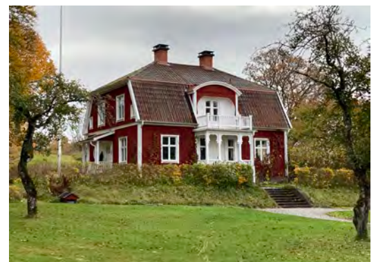
I byn Upphöreda finns två gårdar vars mangårdsbyggnader är uppförda under 1920-talet. Här ses huset på den norra gården, vilket har bevarat sin ursprungliga karaktär. (Upphöreda 1:2)
