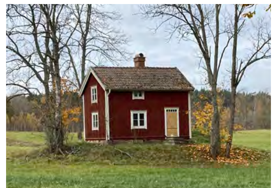
Lundstorpssstugan är ett av de småskaliga bostadshus som ligger utmed vägen och som berättar om levnadsvillkoren för den mindre bemedlade befolkningen under 1800-talet. (Slättna 1:2)
