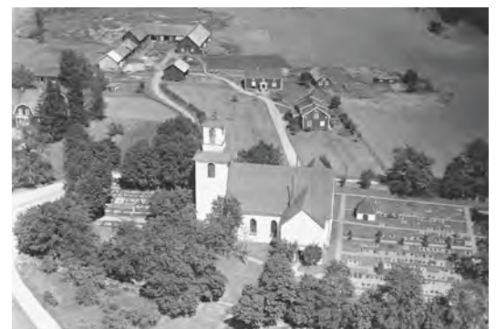
Flygfoto från 1936 över kyrkan, prästgården och lönebostället. Ekonomibyggnaderna låg då samlade öster om prästgårdens mangårdsbyggnad. Foto: Jönköpings läns museum, JM.2001-5-221.
