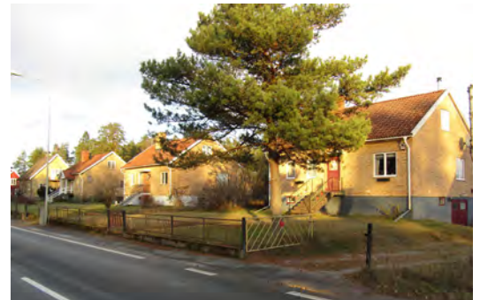
Utmed Marknadsvägen ligger tre likadana tegelvillor från sent 1950-tal. Husens tidstypiska karaktär är välbevarad.
