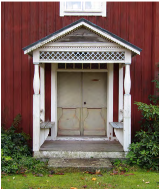
Mangårdsbyggnaden vid den södra gården har en dekorativt utsmyckad veranda. (Hultåkra 1:6)
