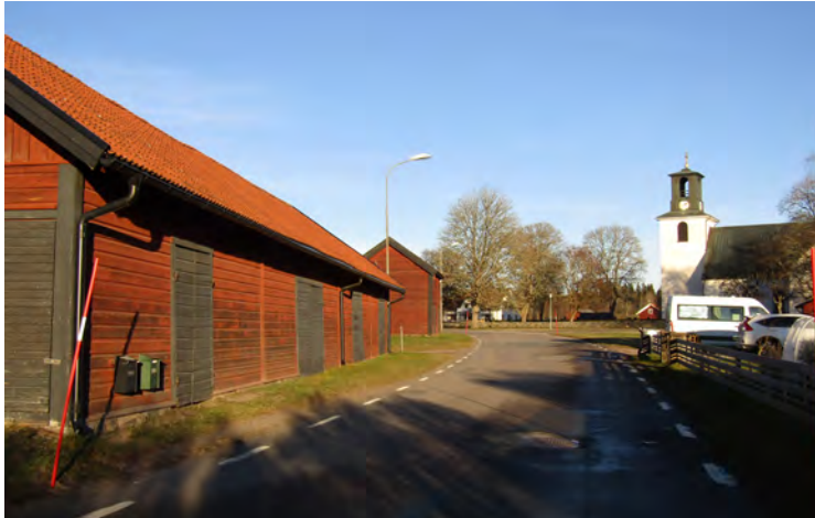
Höreda kyrka med kyrkstallar och sockenmagasin utmed vägen mot Ryningsholm.
