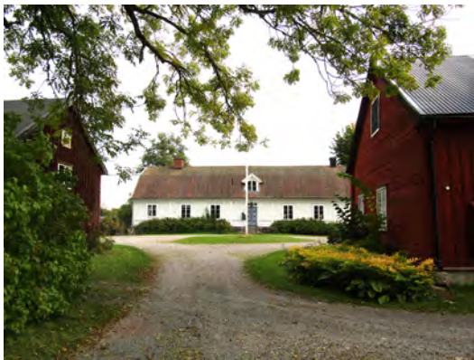
Breviks gård är en av de gårdar i närheten av Eksjö stad som i äldre tid fungerat som militieboställen. Dessa gårdar var en viktig förutsättning för utvecklingen av Eksjö som militärstad. De till gården hörande bodarna, uthusen och ekonomibyggnaderna har viktigt miljöskapande värden.
